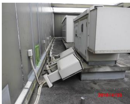
分電盤の転倒（九州電気管理技術者協会 熊本地震の受変電設備等の被害写真より）
