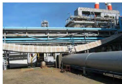
ケーブルダクトが架台から脱落
