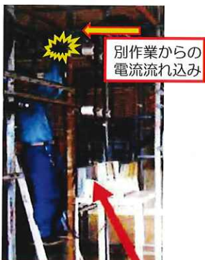
交換作業中に断路器に触れ感電
