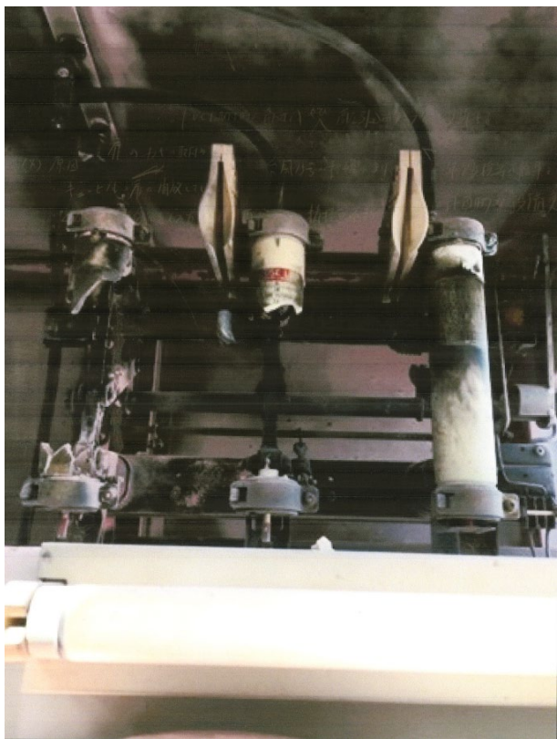
短絡時の発火により焼損したLBS
