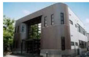
6kV級で受電する事務所、工場等
