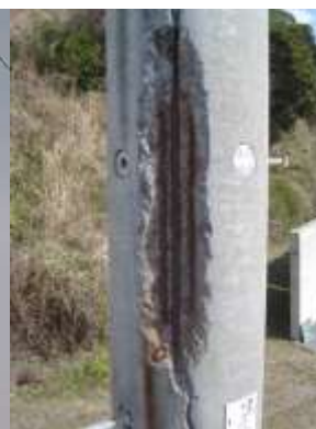
塩害による縦ひびと剥離
