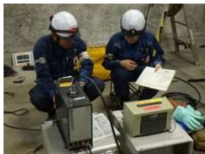
ケーブル劣化診断
