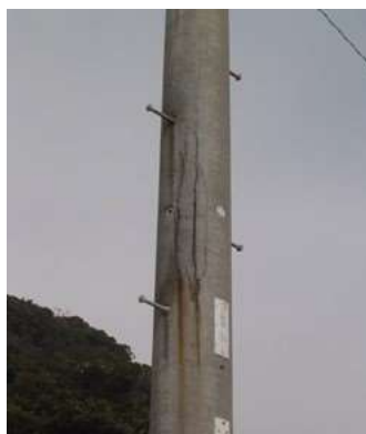
塩害による縦ひびと剥離
