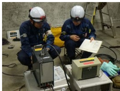
ケーブル劣化診断
